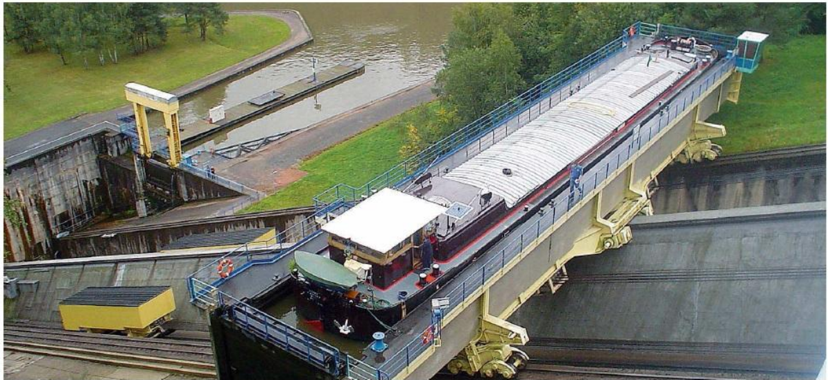
In einem Trog, der an eine riesige Wanne erinnert, werden die Schiffe im Hebewerk von Arzwiller nach oben oder nach unten transportiert. FOTO: K. JOOST-SCHÄFER
